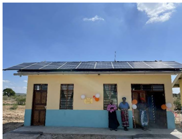
<ソーラーパネルが設置された産科棟>
