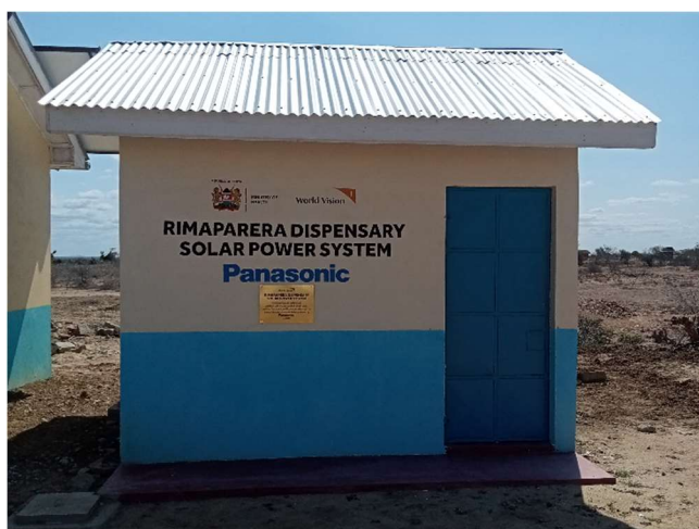
<蓄電システム>
