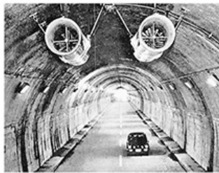
倶利伽羅トンネル初号機（1968年）
