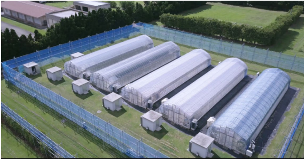
石垣島のITグリーンハウス（比較実証用単棟タイプ）
