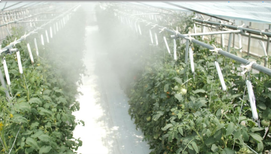
蒸発熱を利用した温度制御用、および加湿による湿度制御用のミスト
