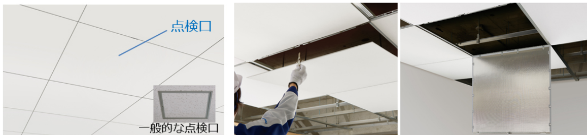
点検口パネルはマイナスドライバーで開閉 パネル全体が開閉する構造
