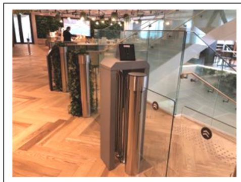
入退セキュリティシステム(KPAS:ケイパス)セキュリティゲート(12F受付横、設置中)
