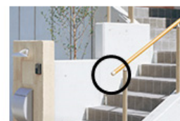
参考：服の袖口が引っかかる可能性のある手すり部の端
