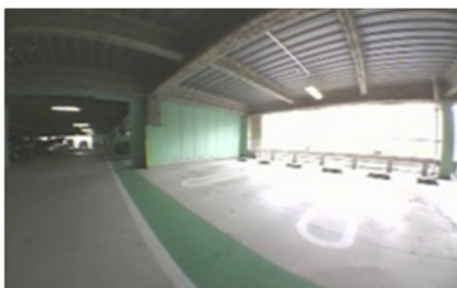
白飛びで駐車スペースの白線が見えづらい
