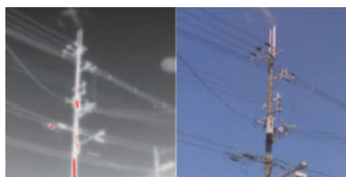
電柱等の熱源検知
