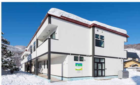
【パナソニック エイジフリーケアセンター札幌南 外観】
