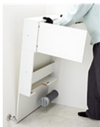
キャビネット設置
