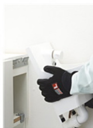
手洗いボール設置
