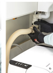
トイレ本体設置 給排水管接続
